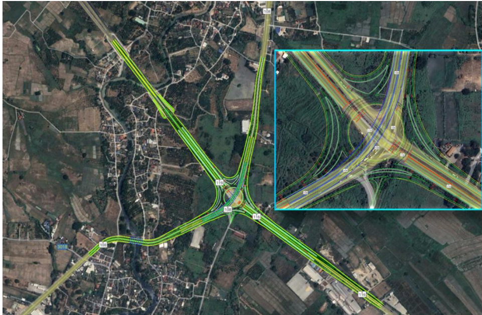
รูปที่ 3.2-6 โครงการทางแยกต่างระดับสันป่าตอง (อุโมงค์) จ.เชียงใหม่ บริเวณแยกเลี้ยวเมืองสันป่าตอง (ทล.108 ตัดกับ ทล.119 และทล.116)
