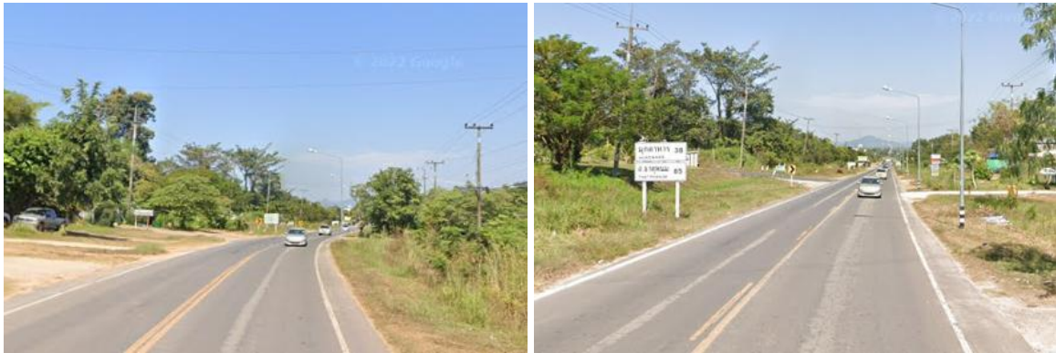
รูปที่ 3.1-23 ทางหลวงแผ่นดินหมายเลข 299
