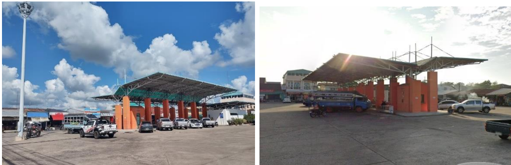
รูปที่ 3.2-10 สถานีขนส่งผู้โดยสารอำเภอสุวรรณภูมิ
